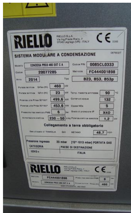
Figura 4.11 - Targhetta caldaia
