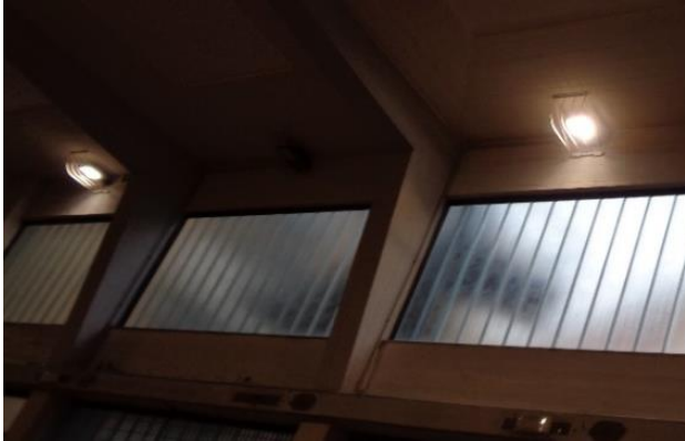
Figura 4.15 - Particolare dei corpi illuminanti fluorescenti 1x58W presenti al piano terra
