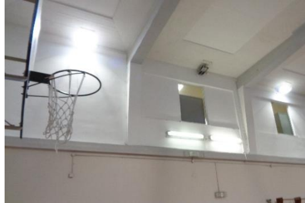
Figura 4.15 - Particolare dei corpi illuminanti fluorescenti 1x58W presenti al piano terra
