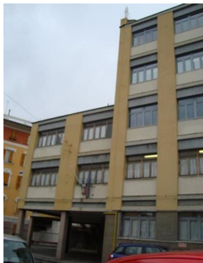
Figura 1.1 – Facciata sud del fabbricato
