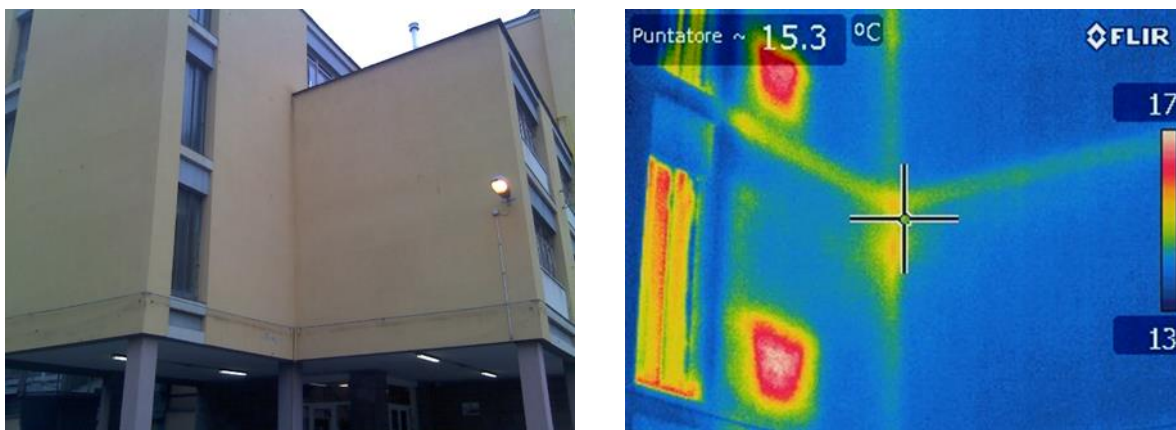
Figura 4.2 – Rilievo termografico della parete
