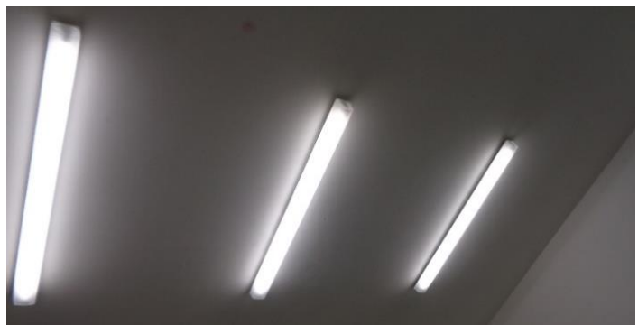
Figura 4.16 - Particolare dei corpi illuminanti fluorescenti 2x58W installati nelle aule e nei corridoi
