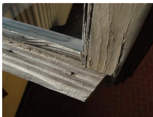
Figura 4.3 - Particolare dei serramenti
