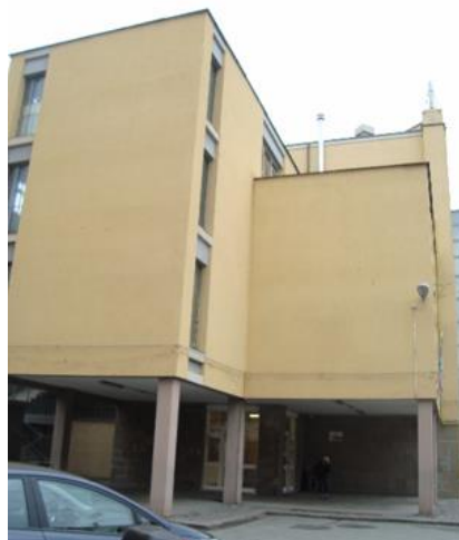
Figura 4.1 - Particolare della porzione di involucro esterno del fabbricato
