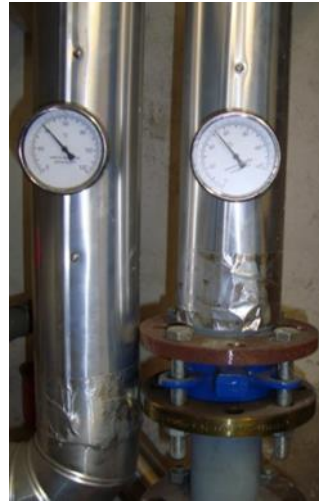
Figura 4.7 – Sonde di temperature sui circuiti di ritorno del fluido termovettore
